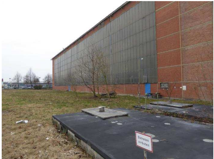
Foto 9 Ostseite der Produktionshallen.
