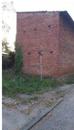
Foto 46: Außenansicht des in Ab- bildung 9 gezeigten Ge- bäudes an welchem sich sehr wahrscheinlich ein- zelne Spaltenquartiere von Zwergfledermäusen befinden, im Vorder- grund ein in unmittelba- rer Nähe aufgestelltes akustisches Aufnahme- system zur Kontrolle ausfliegender Tiere.
